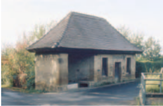
Brunnenhaus im Breitenloch, 1988 Installation
